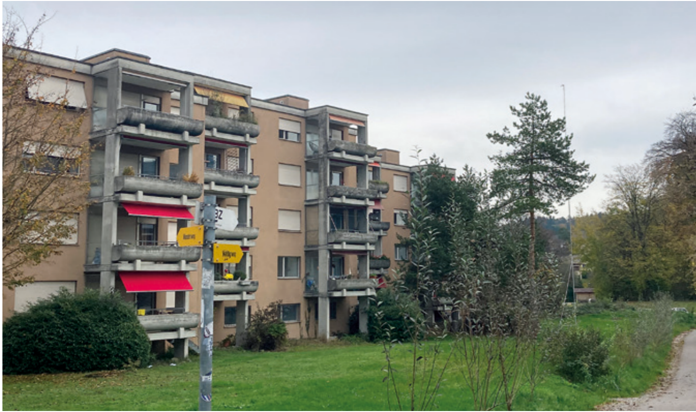
In der Überbauung aus den 80er-Jahren zwischen Rütlistrasse und Moosburgpark fanden viele Familien eine Heimat. Es stand eine Renovation an. Die Zürich Anlagestiftung hat sich für Rück- und Neubau entschieden. Foto November 2022
