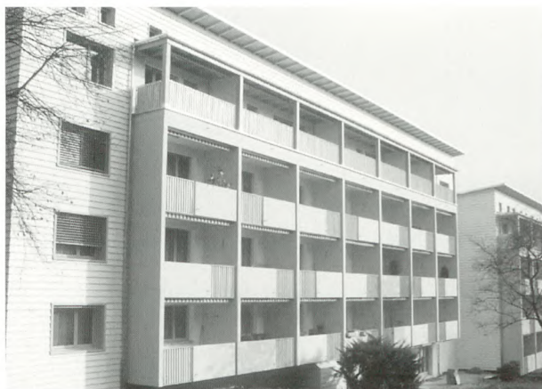
Die aufgestockte und erneuerte Alterssiedlung an der Wiesenstrasse in Effretikon. (Kbz)
