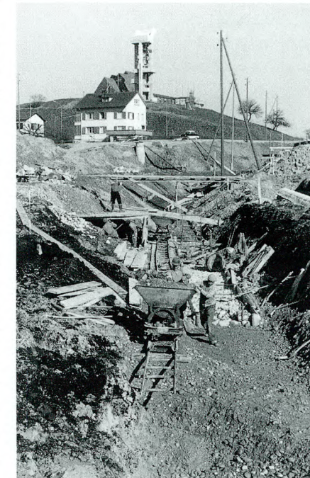
Von Gastarbeitern tiefergelegt: der Grendelbach in Effretikon (1961).
