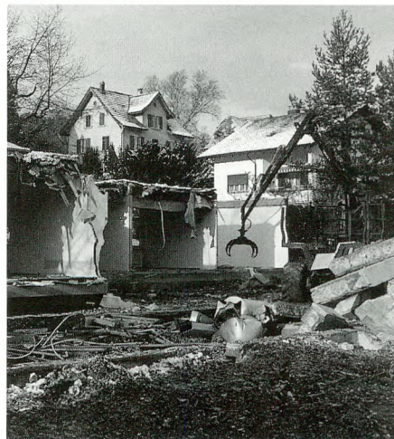
Abbruch des Verwaltungspavillons. (um)
