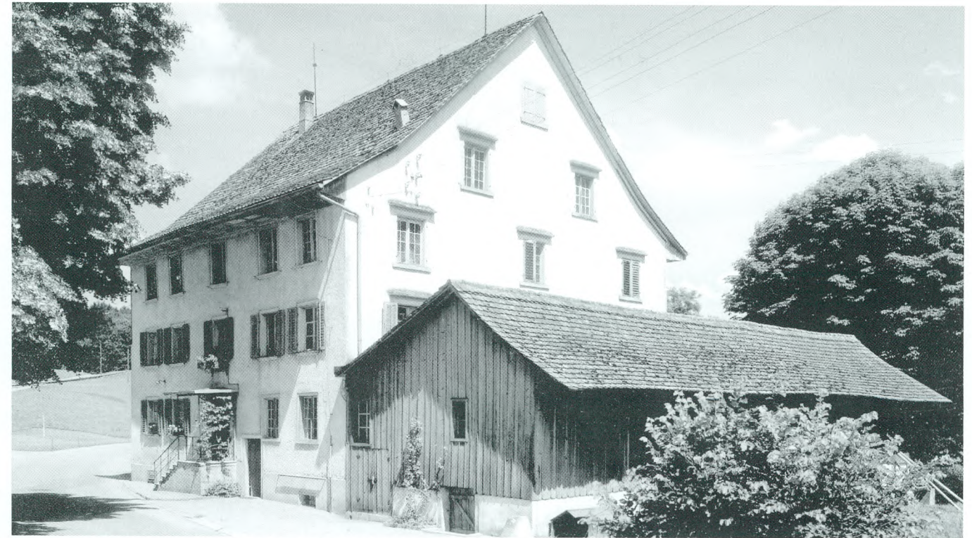
Die Würglenmühle im Juli 1960. Ganz links im Bild ist die 1973 gefällte Hoflinde zu erkennen, rechts der Sägereianbau (heute Restaurant).
