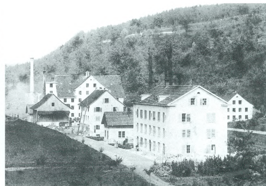
Die Spinnerei Oberkempttal um 1885 mit zwei Hochkaminen für die Dampfheizung und die Dampfmaschine. Im Vordergrund die Kosthäuser.
