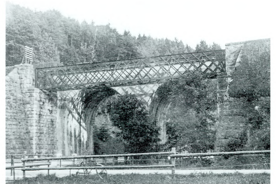
Der Mannenberger Viadukt um 1910. Vor der Steinbrücke der NOB ist die eiserne Brücke der Nationalbahn zu erkennen, die während des Ersten Weltkrieges abgebrochen wurde.
