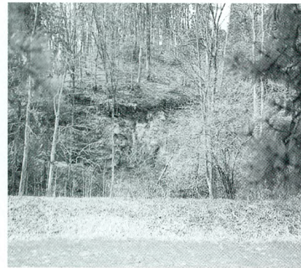
Der Kanaldamm bei Oberkempttal.
