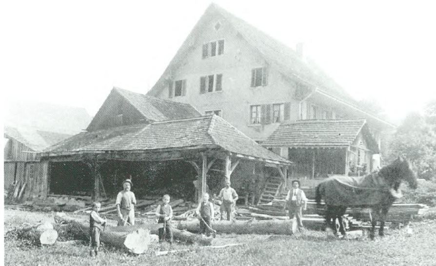
Die ehemalige Sägerei zwischen Talmühle und Kempt. Die um 1910 aufgenommene Fotografie zeigt den damaligen Talmüller Leonhard Hoch und seine Helfer.
