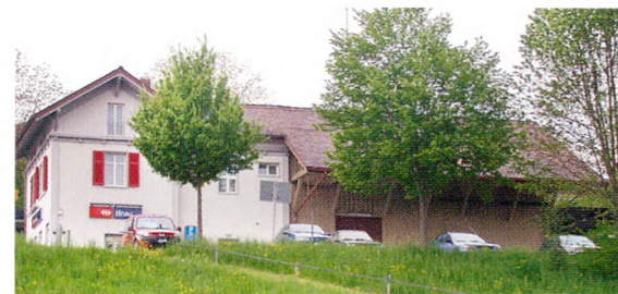
Die künftige Nutzung des Bahnhofs Illnau ist noch ungewiss.
